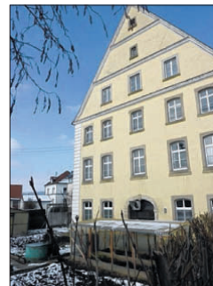
Vom Hintereingang im Garten könnte die Oberschaffnei besser erschlossen werden: Ein Aufzugsturm brächte barrierefreien Zugang, ein Treppenhaus weitere Fluchtwege. Foto: Andreas Hacker
